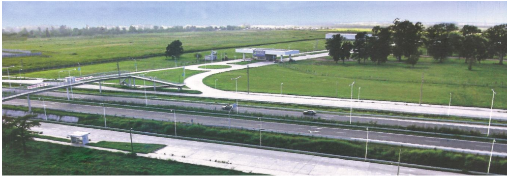
Vista área: Autovía 3 y Acceso al Parque Virrey del Pino. Fuente: Inmobiliaria Impacto
