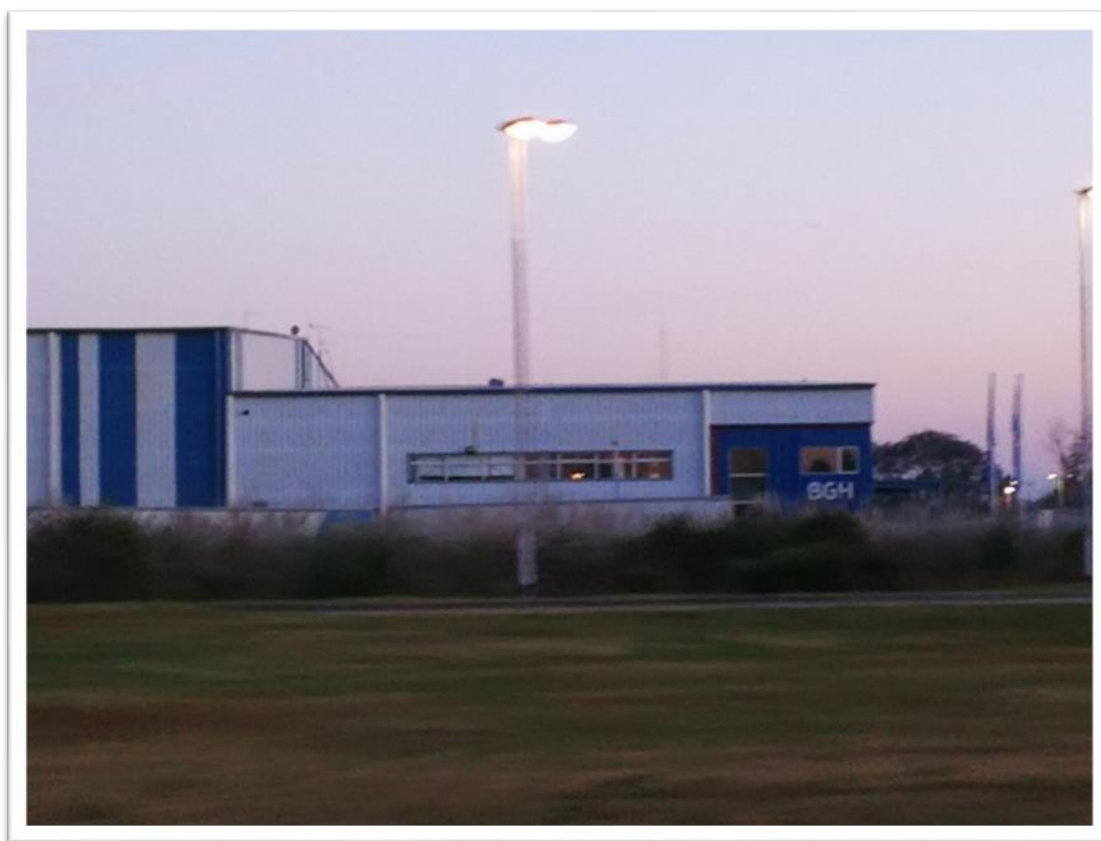
Depósito de Producto Terminado en Spegazzini, Partido de Ezeiza, Buenos Aires. Fotografía tomada por la autora en el marco de esta investigación, junio del año 2018.
