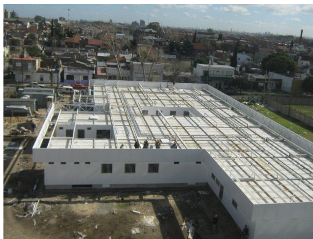
UPA en construcción
