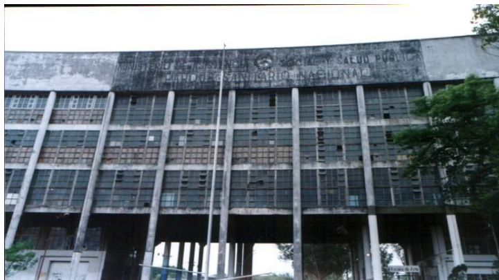
Frente del edificio del que sería un Parque Sanitario Nacional 234 .
