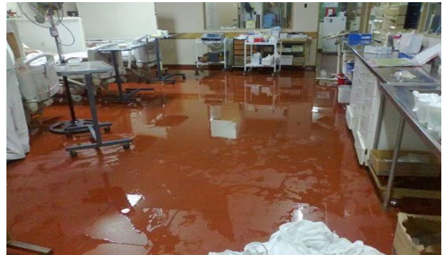
Interior del Hospital Paroissien inundado 456
