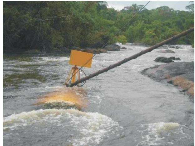
Figura 2. Instalación de Micro Turbinas en ríos
