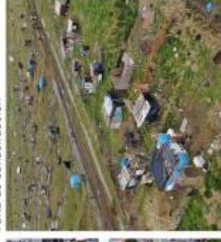
Falta de consolidación
