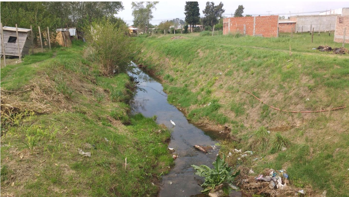
Foto 13. Arroyo Chacón en el cruce de RN3. En ambas márgenes se observan construcciones de todo tipo. La presencia de fauna local sería un buen indicador de la calidad de las aguas.
