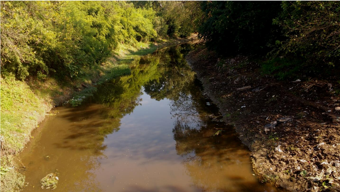
Foto 9. Arroyo Morales cruce sobre RN3. Sus condiciones son mejores debido a que en esta región no hay asentamientos. De todas maneras, se observan residuos domiciliarios.
