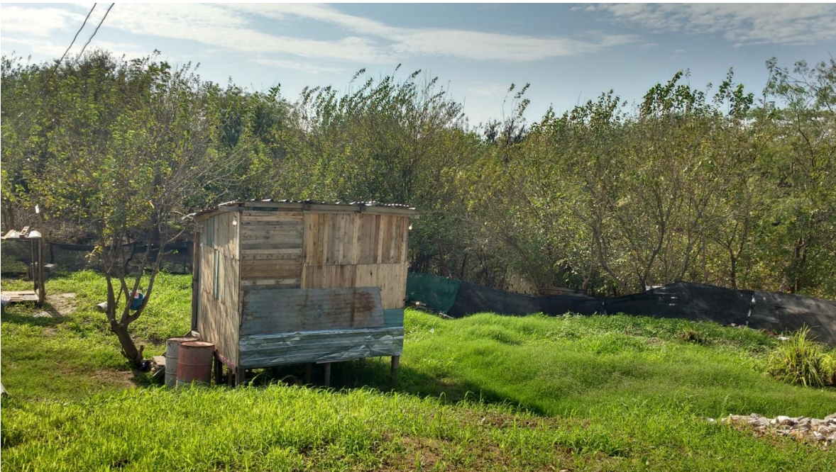
Foto 15. Construcción en una de las márgenes del río Matanza.
