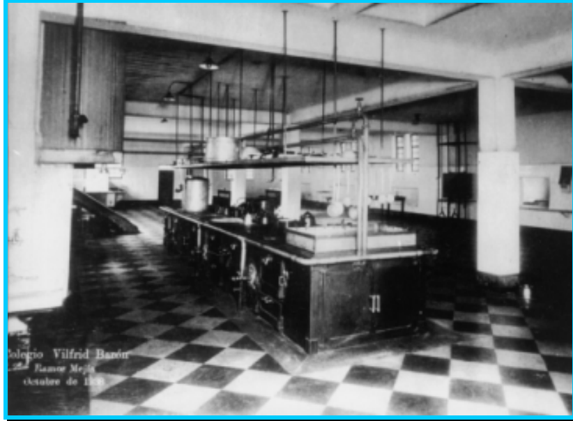
Cocina del colegio
