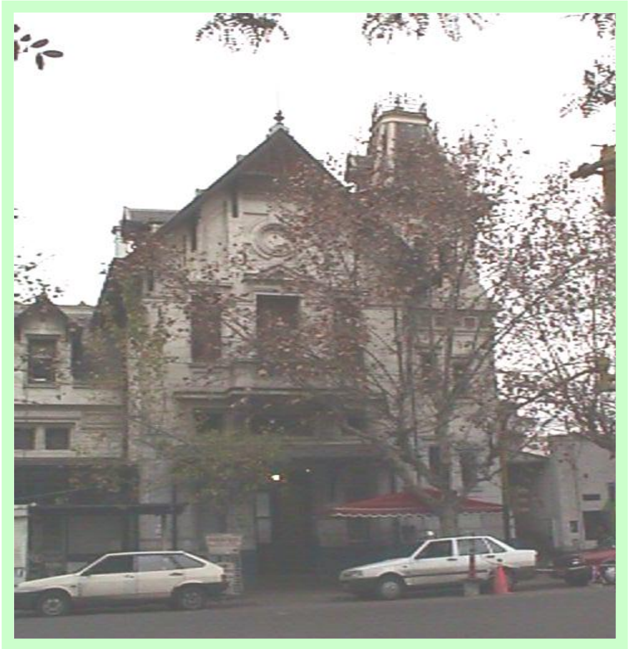
Edificio de la estación de Ramos Mejía lado Norte
