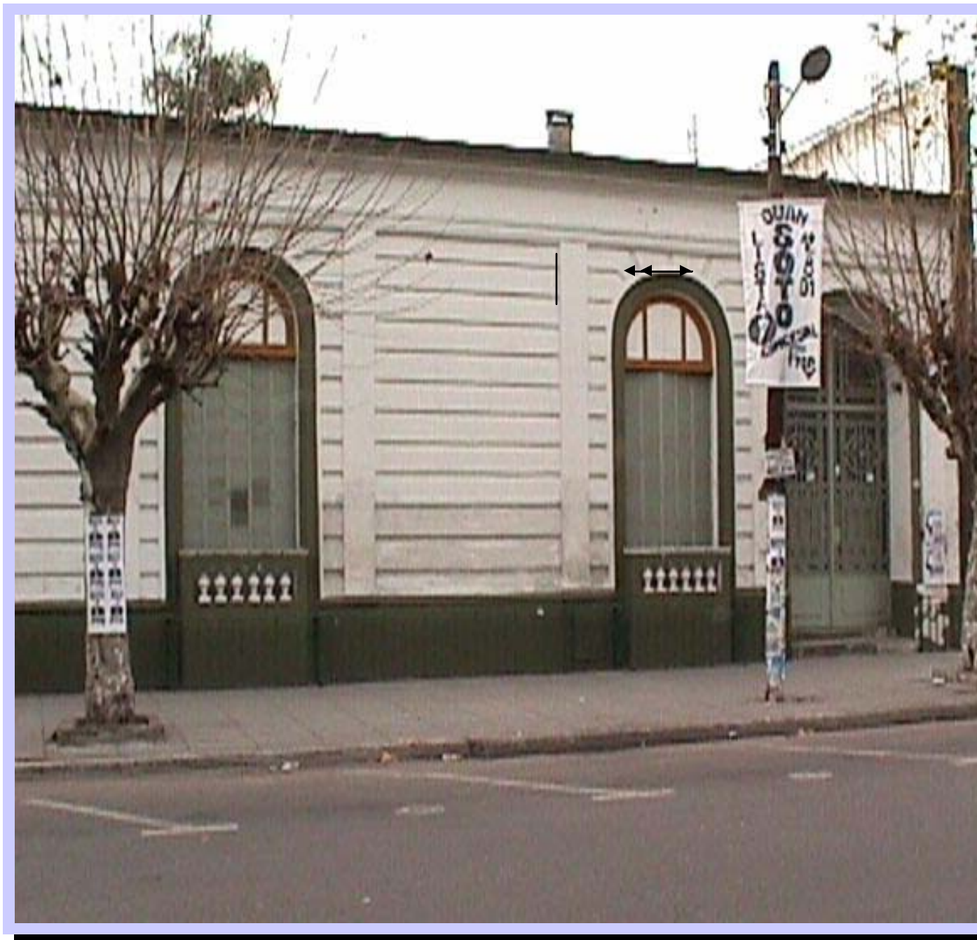
Edificio del Normal de San Justo, frente a la Plaza San Martín
