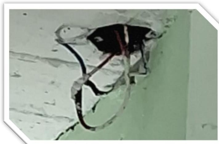
*Ilustración 44. instalación eléctrica expuesta en zona de vestuarios. Elaboración propia.*
