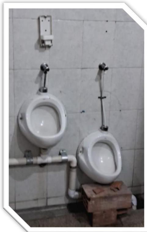
*Ilustración 15. Mingitorios en mal estado en los sanitarios del salón. Elaboración propia.*
