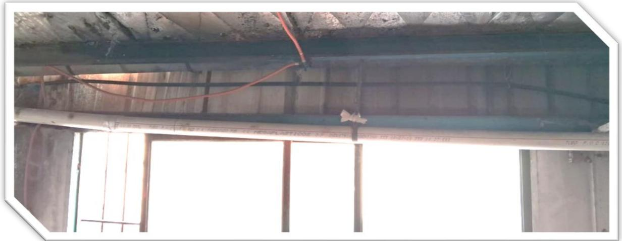
*Ilustración 9. Trazado eléctrico coincidente con el pluvial en el entrepiso del salón. Elaboración propia.*
