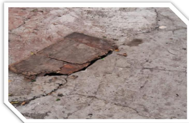
*Ilustración 19. Rotura con la instalación cloacal expuesta en el estacionamiento. Elaboración propia.*
