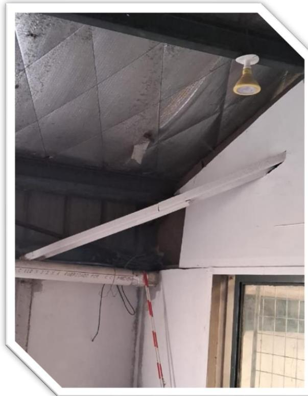
*Ilustración 8. Mampostería sostenida con un perfil en mal estado en el entrepiso del salón.
