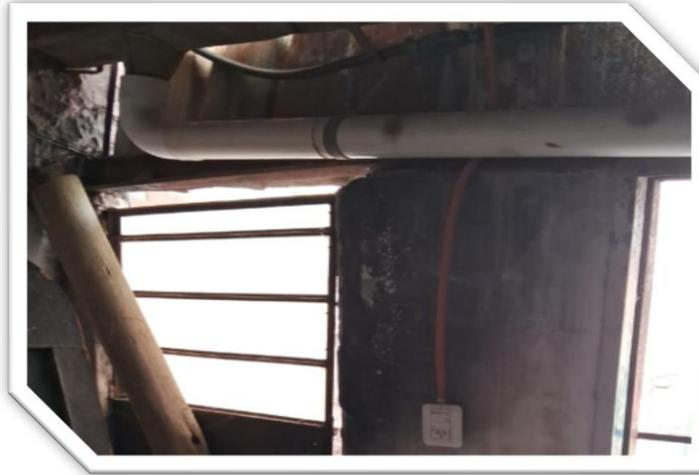
*Ilustración 14. Traza del pluvial coincidente con la eléctrica en el entrepiso del salón. Elaboración propia.*
