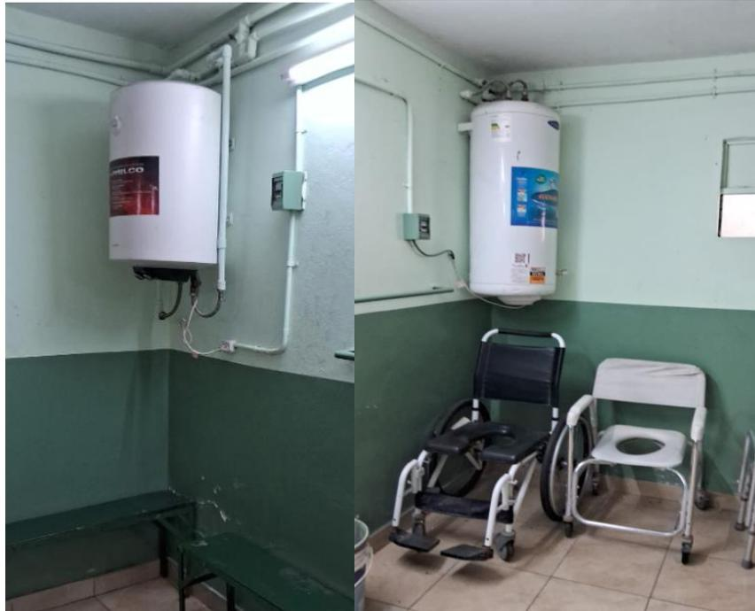
*Ilustración 11. Ubicación incorrecta de termotanques en los vestuarios. Elaboración propia.*
