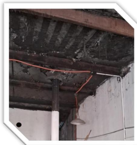
*Ilustración 7. Estructura metálica de la cubierta dañada por el accionar del fuego.
