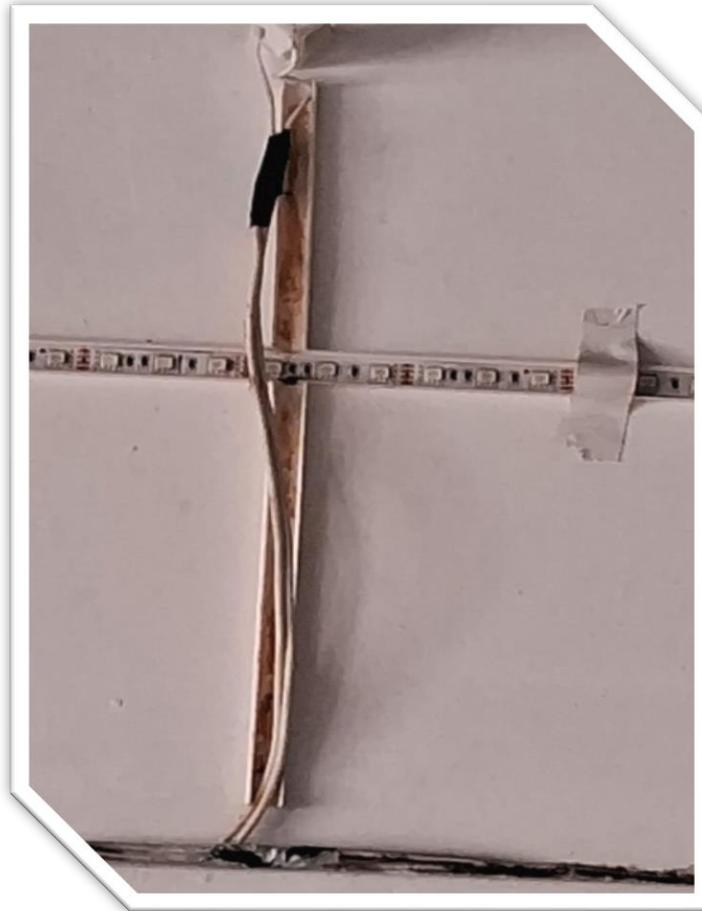
*Ilustración 43. Aplique led sostenido con cinta de papel y conexiones expuestas en el entepiso del salón. Elaboración propia.*
