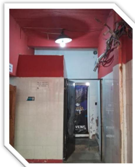
*Ilustración 12. Trazado eléctrico expuesto en el salón. Elaboración propia.*
