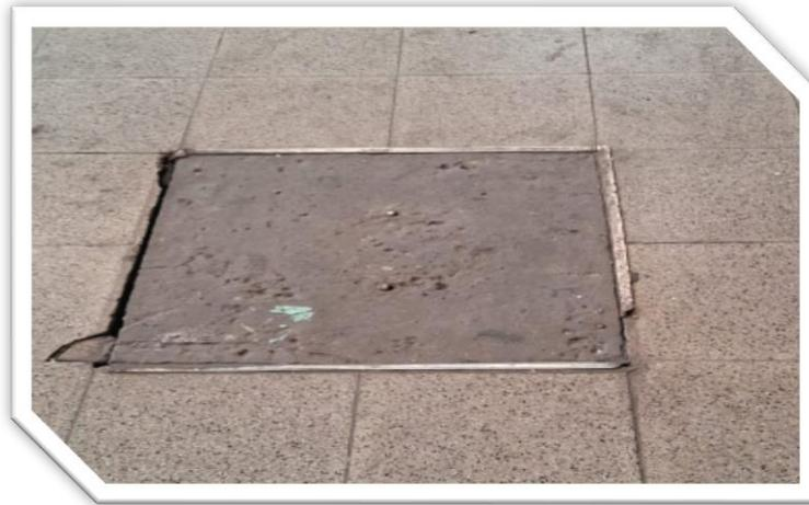
*Ilustración 18. Tapas de cámara de inspección en mal estado. Elaboración propia.*
