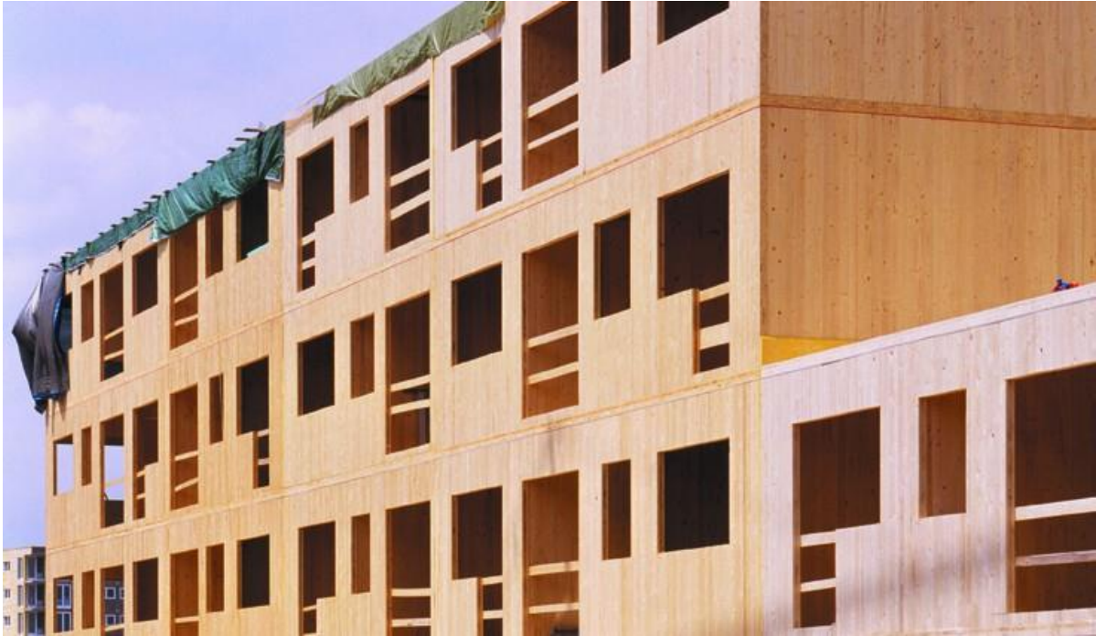
Figura 1. Vivienda colectiva en CLT. Fuente: http://www.cedarlan.ie/cross-laminated-timber
