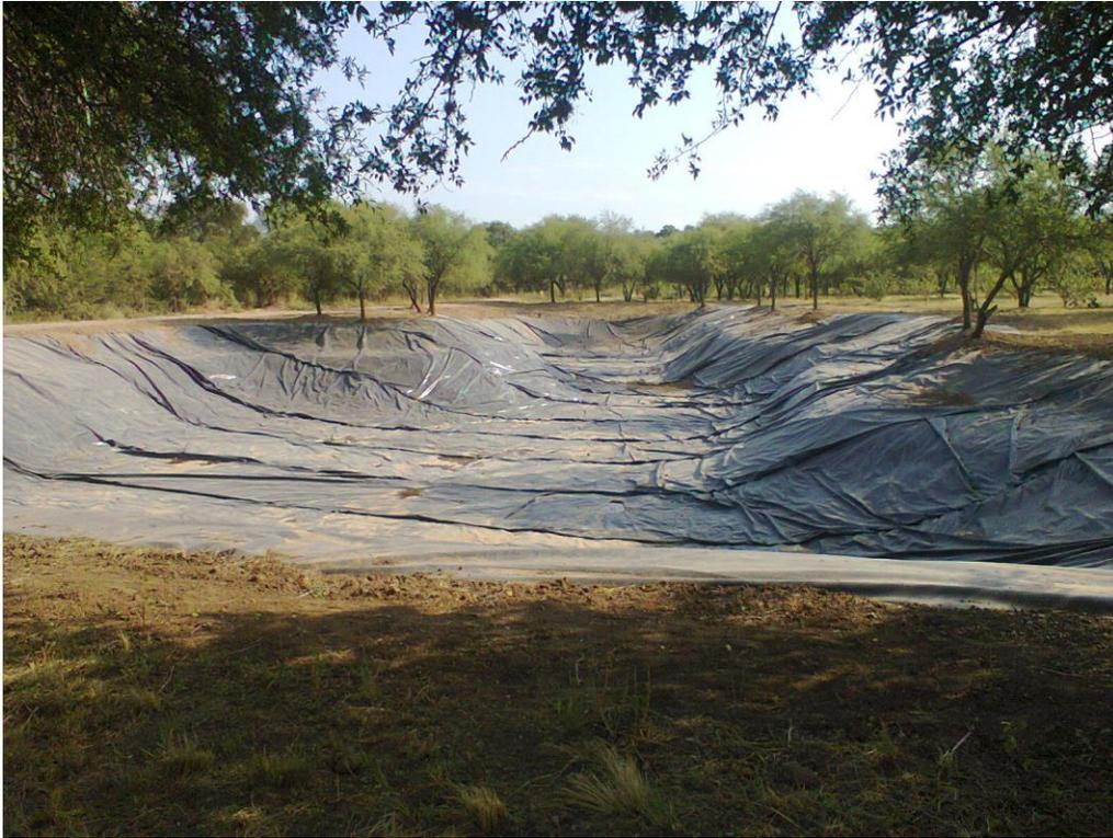
Figura 19. Construcción de represas para el almacenamiento del agua de lluvia
